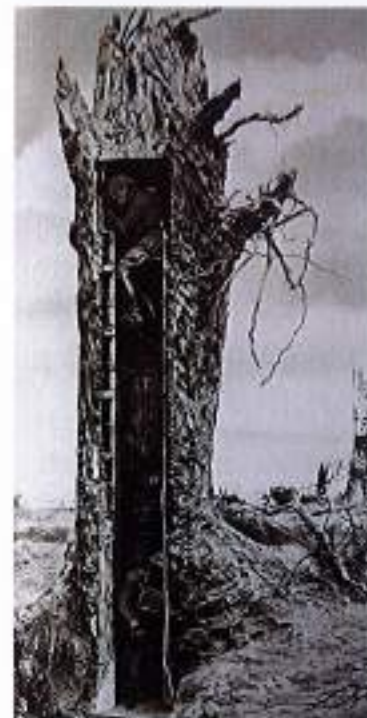
Position de deux observateurs à l'intérieur d'un arbre observatoire blindé, Oise, mars 1917. © "Tromper l'ennemi", p. 129
