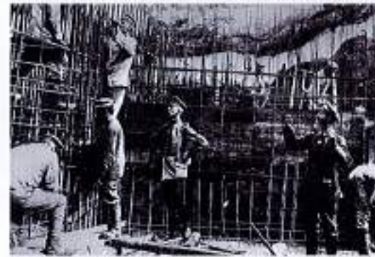
Construction d'un blockhaus sur la ligne Hindenburg, ligne de défense allemande extrêmement bien fortifiée. © Fonds documentaire Alain Jacques
